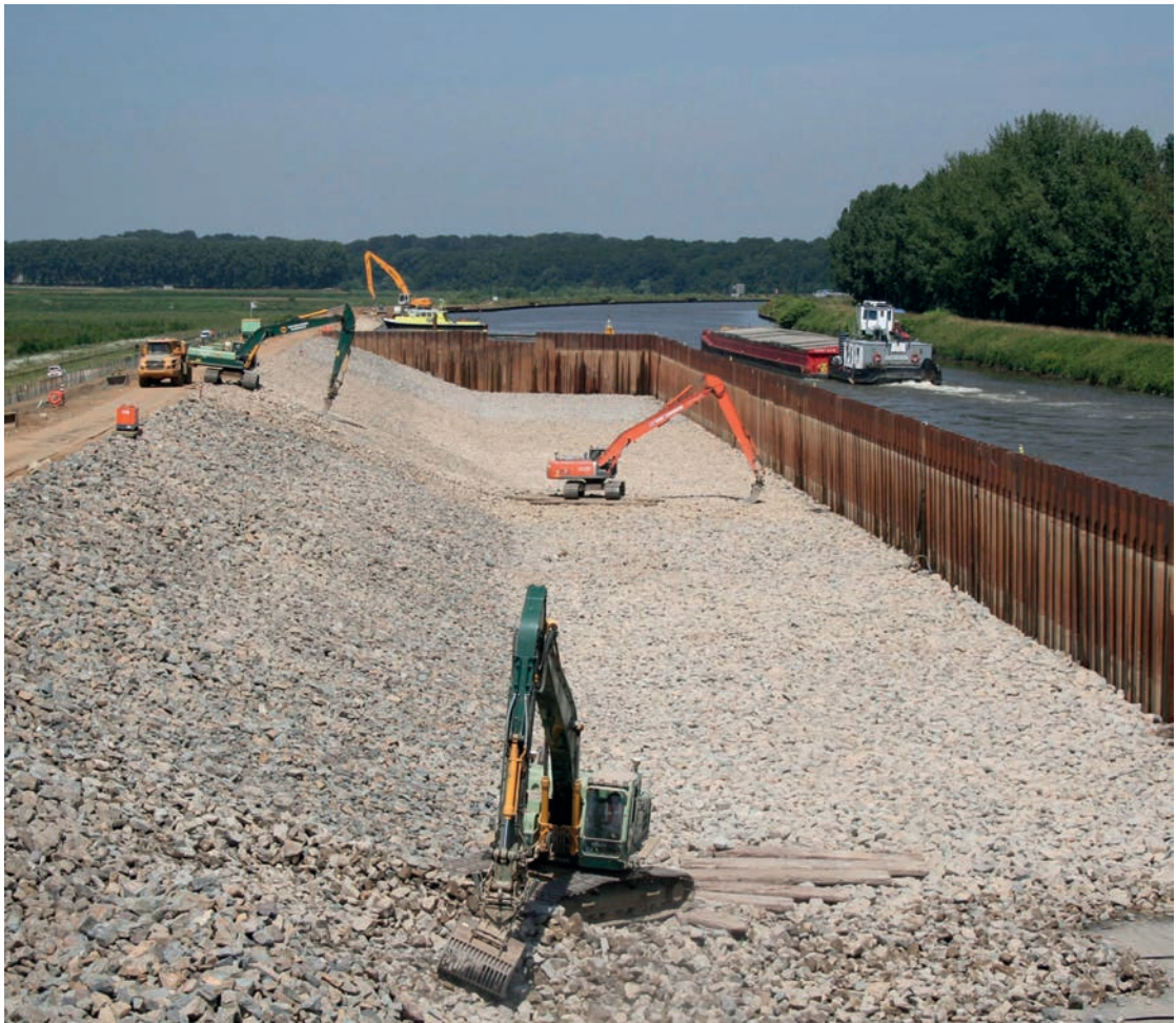
29. Werkzaamheden aan Julianakanaal (Bron: Schuttevaer Maritiem Nieuws, 2 april 2022)
